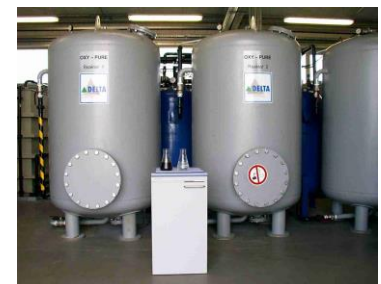
OXI-PURE®-Verfahren zur katalytischen Nassoxidation, ehemalige Kokerei Zwickau
